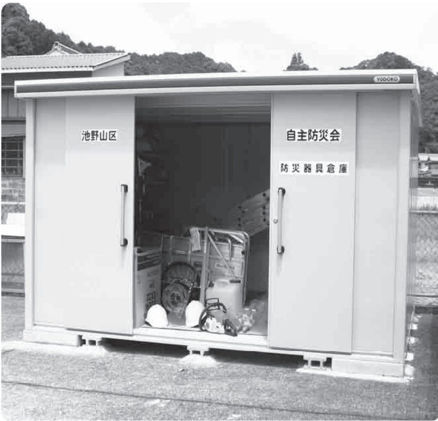
資機材倉庫（池野山）
