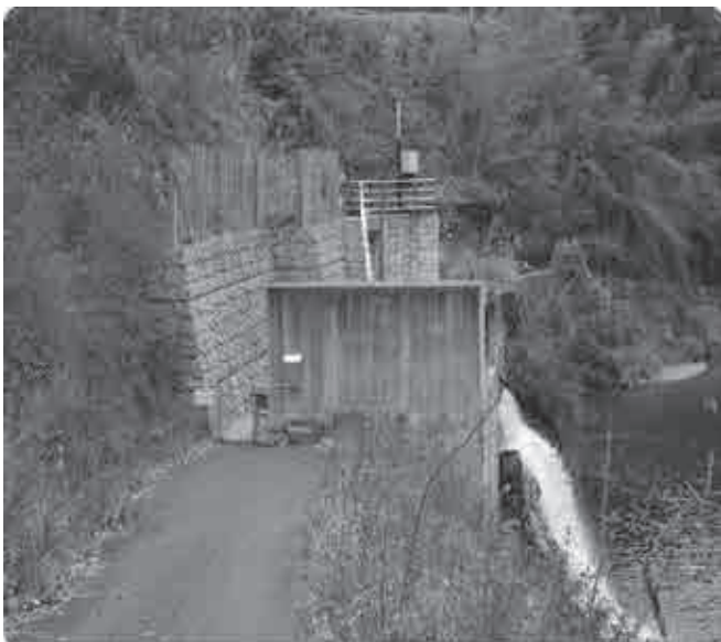
6mの落差を利用した小水力発電所
