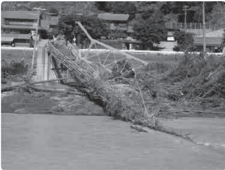
倒壊した蔵土橋
