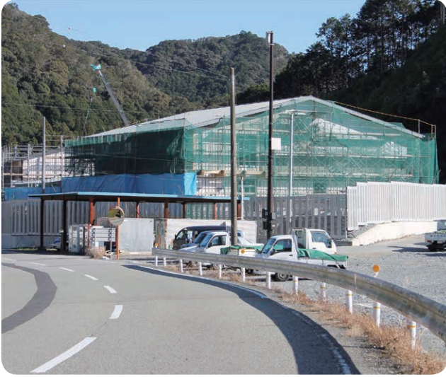
完成間近の保健福祉センター
