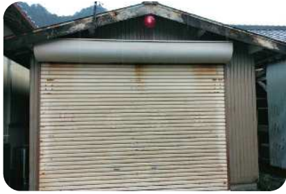
池野山消防車庫
