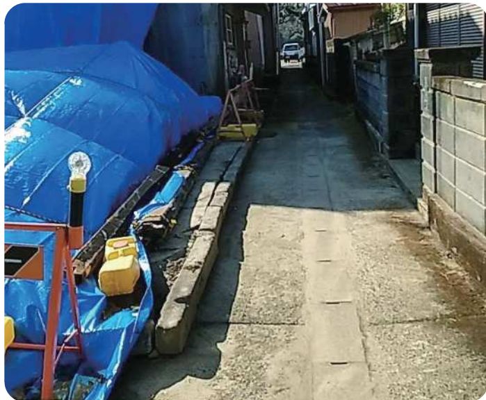
整備された避難路
