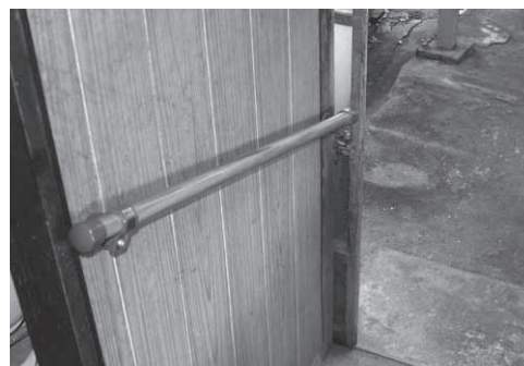
転倒防止のための手すり
