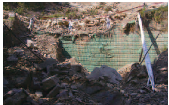
崩壊したの道路の測量(松根)
