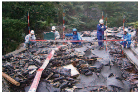
流水により破損した舗装の測量(松根)
