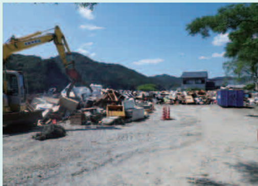
ごみの収集作業(高池)
