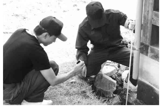
住家の被害認定調査
