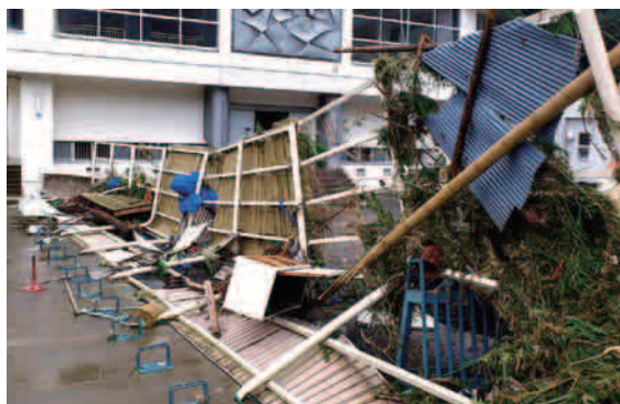
明神中自転車置場（修復前）
