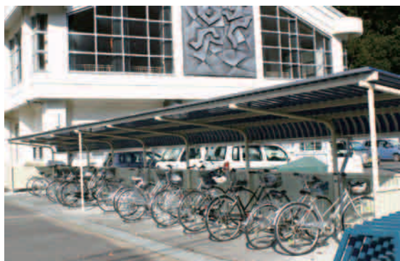
明神中自転車置場（修復後）
