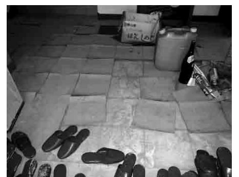
浸水で剥がれた床 (高池複合センター)
