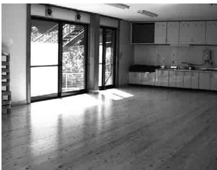
床の修繕完了後
