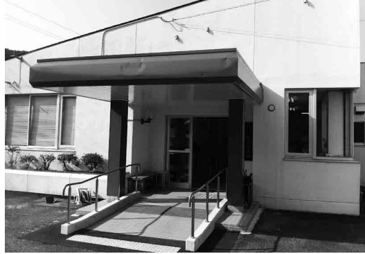
改修工事が完了した七川診療所
