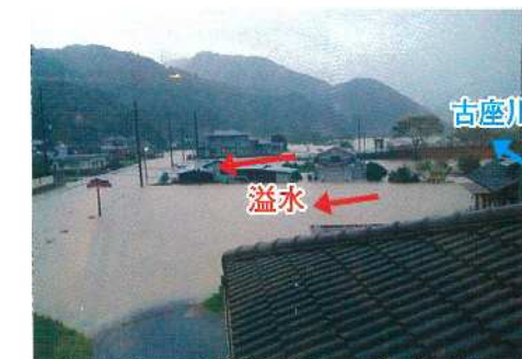
平成23年9月3日外水はん濫の状況 (明神地区潤野橋付近)
